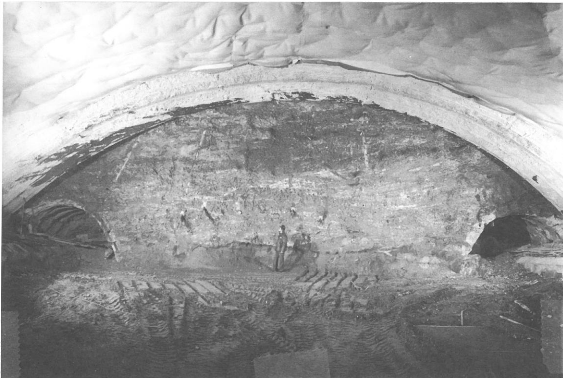
Fig. 12 - Scavo dell'arco di calotta. Si notano i piedritti già gettati nei due cunicoli laterali.
